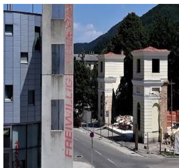
Blick aus dem Archivfenster - der Abriss am 13.08.2019
